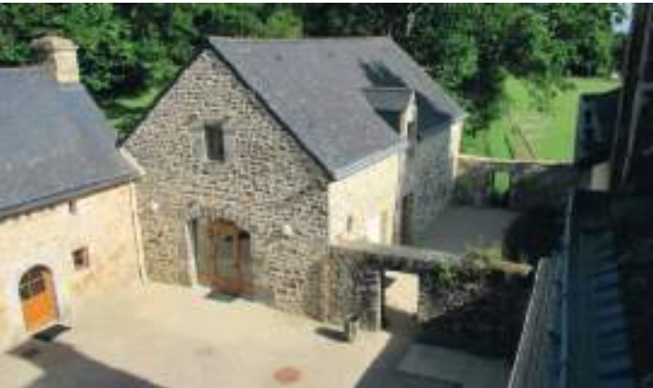
Médiathèque, maison des associations - Lanvaudan
